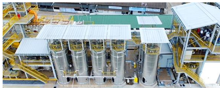
図4 余剰バガスを用いたセルロース糖の製造プラント（タイ、ウドンタニ県）
